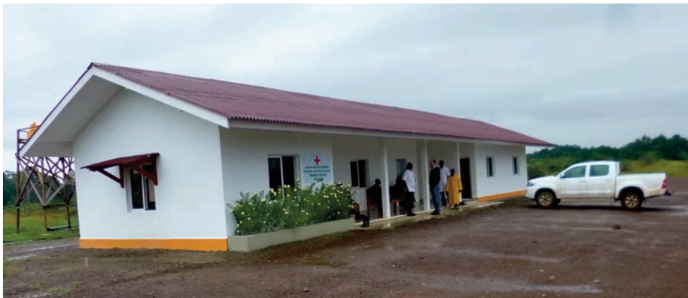
Dispensaire sur la base de vie d'Olam à Mouila
