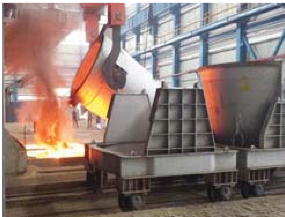
Second four du Centre métallurgique de Moanda Comilog
