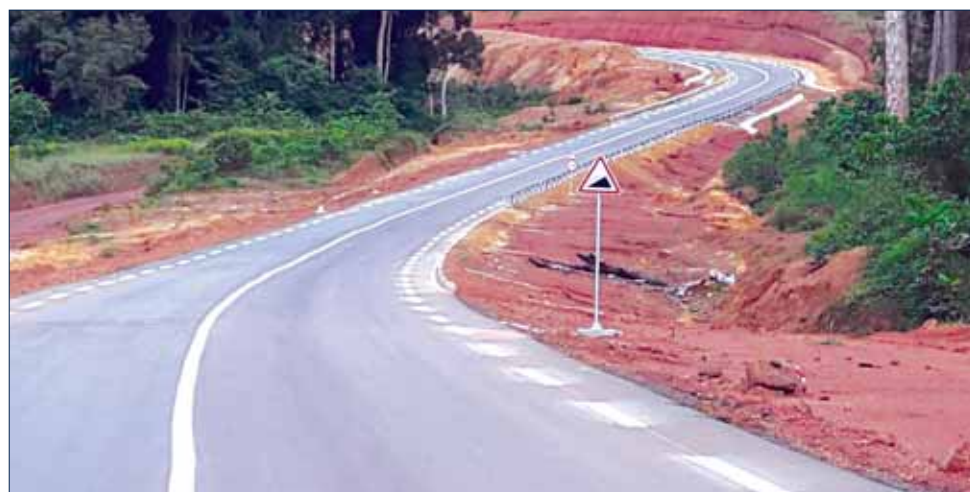
Une vue de la route après travaux
