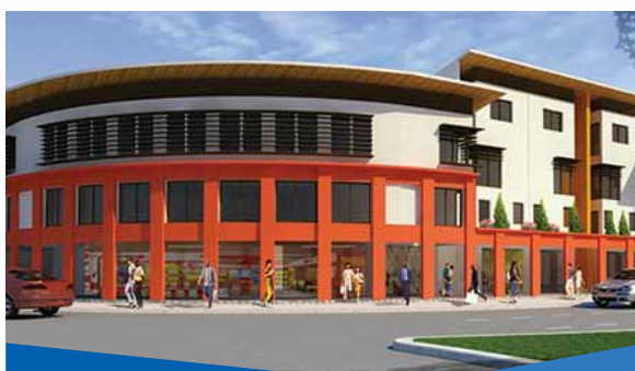
Immeuble Commercial d'Angondjé (Vente terrain 1200m 2 TF + projet immeuble)
