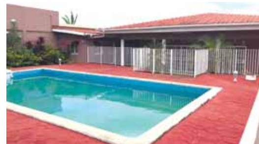
Villa haut standing avec piscine à Angondjé
