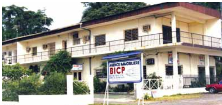
Ancien bâtiment BICP 1984
