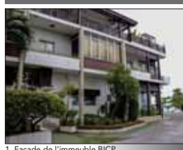
1. Façade de l'immeuble BICP
