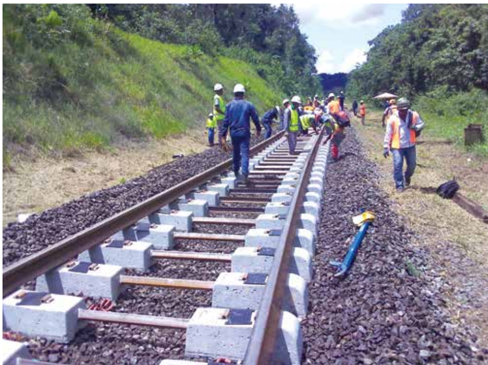
■ Travaux de renouvellement de la voie
