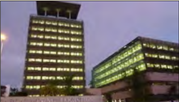
Vue extérieure GML
