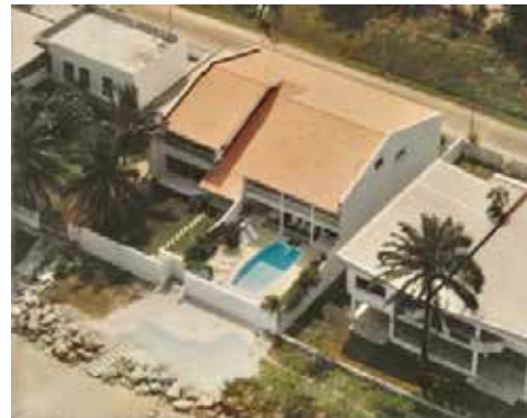
Construction de villas jumelées à Tahiti (1990)
