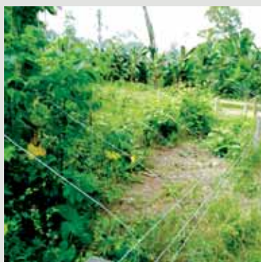
Clôture électrique installée dans le cadre de la lutte contre la faune
