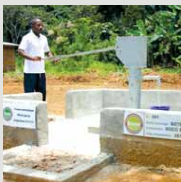
Installation d'une pompe hydraulique à eau dans un village
