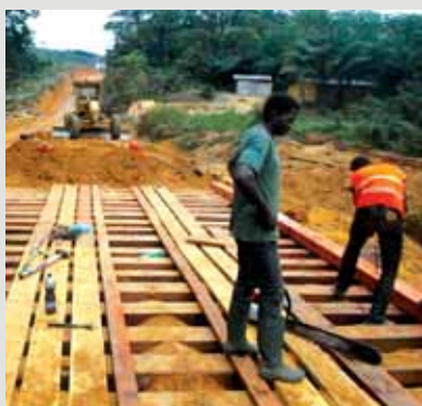
Réhabilitation d'une route rurale et construction d'un pont...
