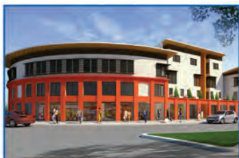
Immeuble Commercial d'Angondjé
